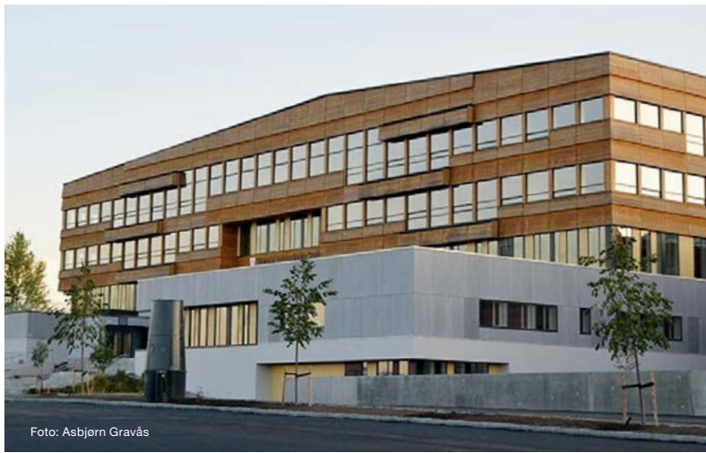
Norwegens erste Nullenergie-Schule: Das Heimdal-Gymnasium in Trondheim. Die Lüftung war einer der entscheidenden Erfolgsfaktoren des Projekts, um die Energieanwendung möglichst gering zu halten. IV Produkt lieferte 54 Geräte mit Kanalanschlüssen auf der Oberseite, hoher Wärmerückgewinnung und einem SFP-Wert von 0,5.
